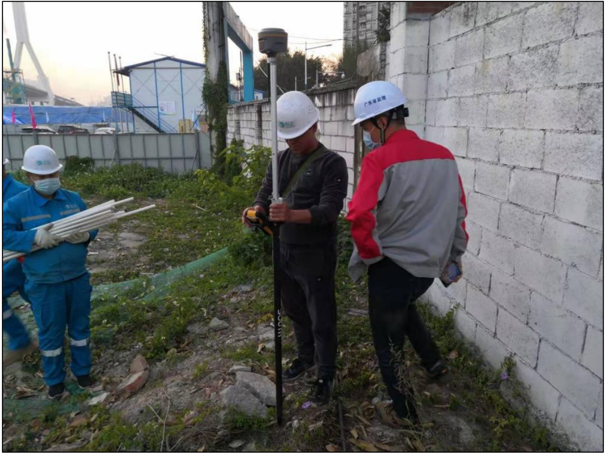
图 3.4-3 1#基坑现场坑顶拐点范围划线
