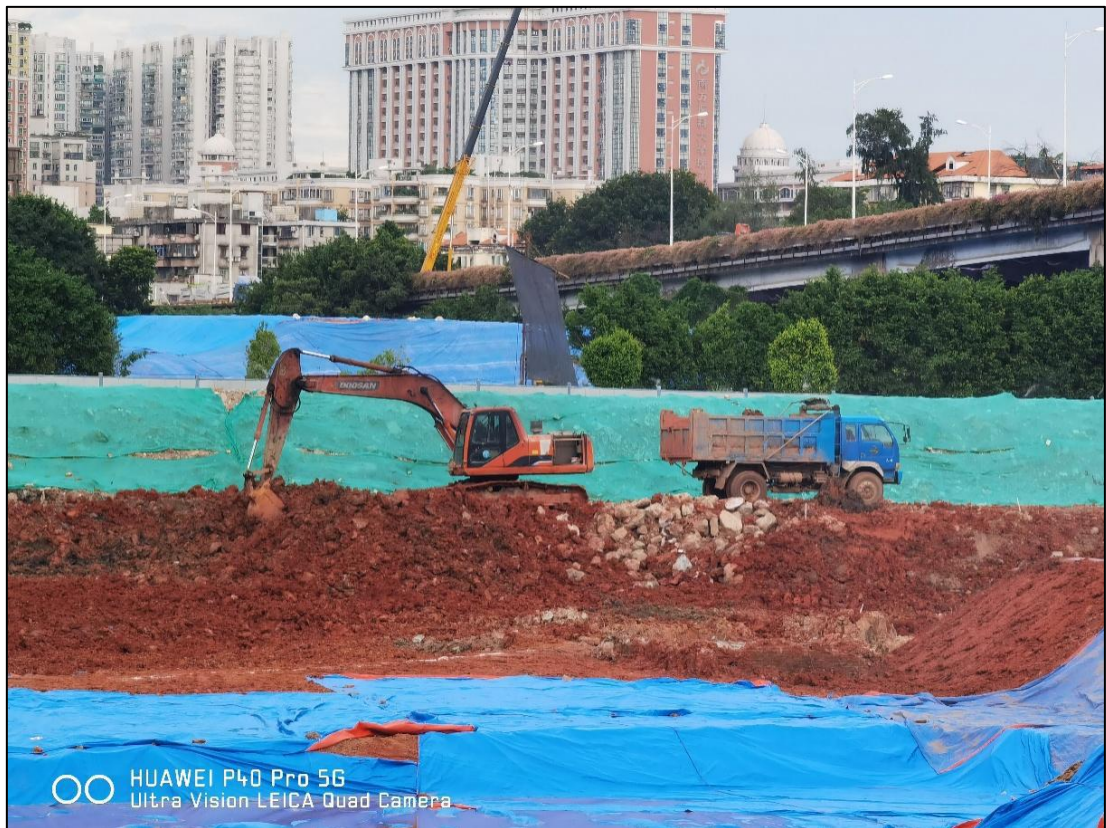
图 3.4-6 1#基坑污染土壤转运
