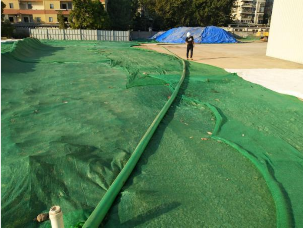
图 3.5-13 基坑废水收集
