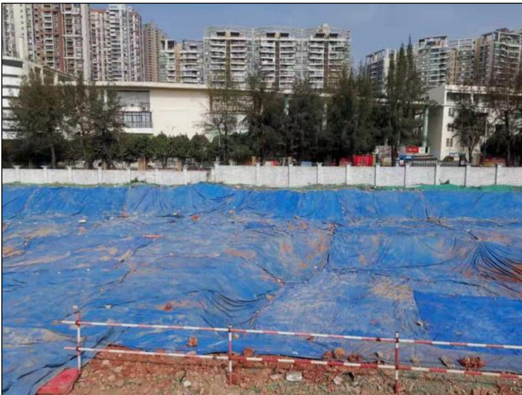
图 3.5-5 1#基坑苫布覆盖
