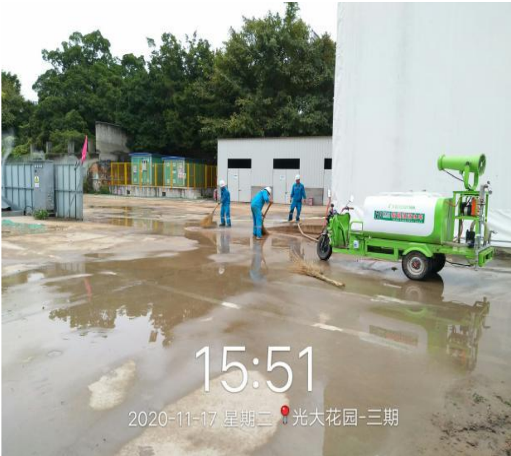
图 3.5-6 现场施工道路洒水清理
