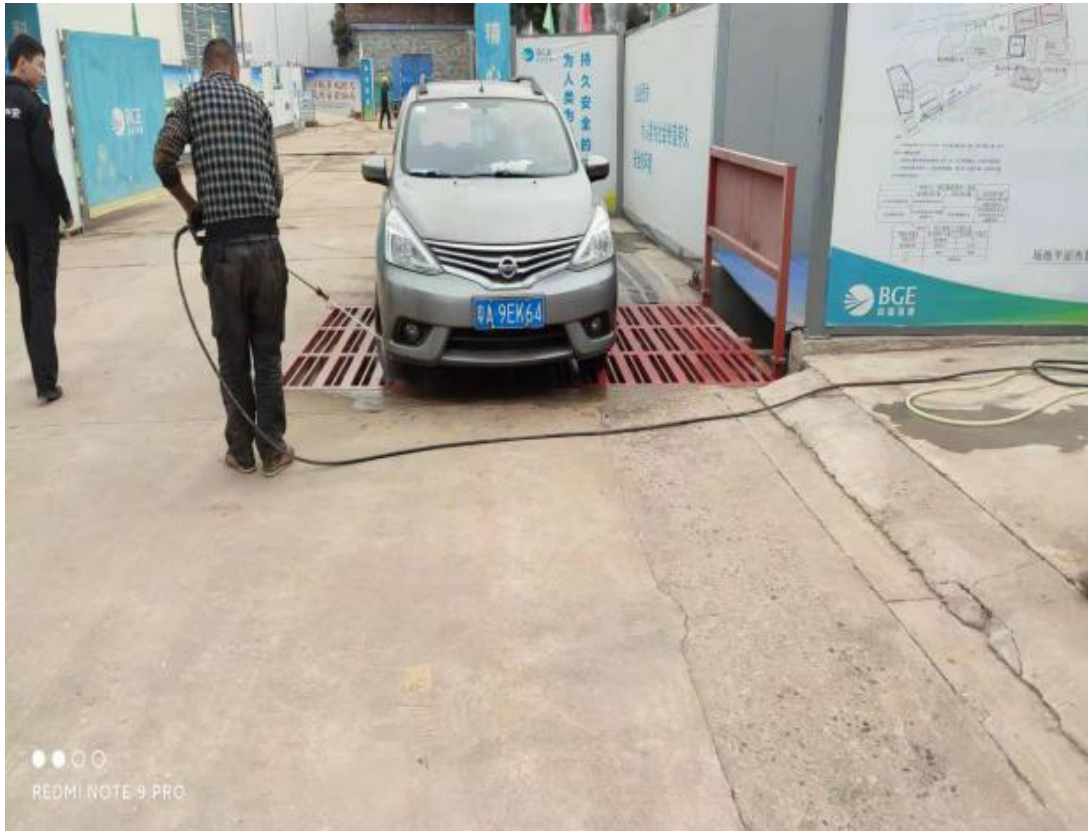
图 3.5-11 出场车辆冲洗情况
