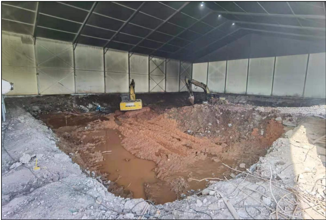
图 3.4-5 1#基坑污染土壤清挖
