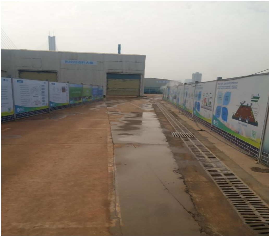
图 3.5-9 现场围挡喷淋系统运行
