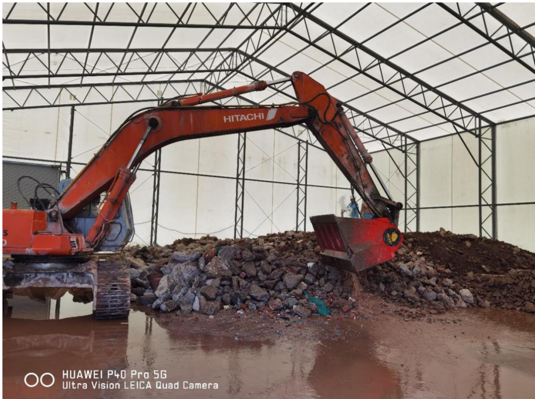
图 3.4-9 1#基坑筛上物冲洗
