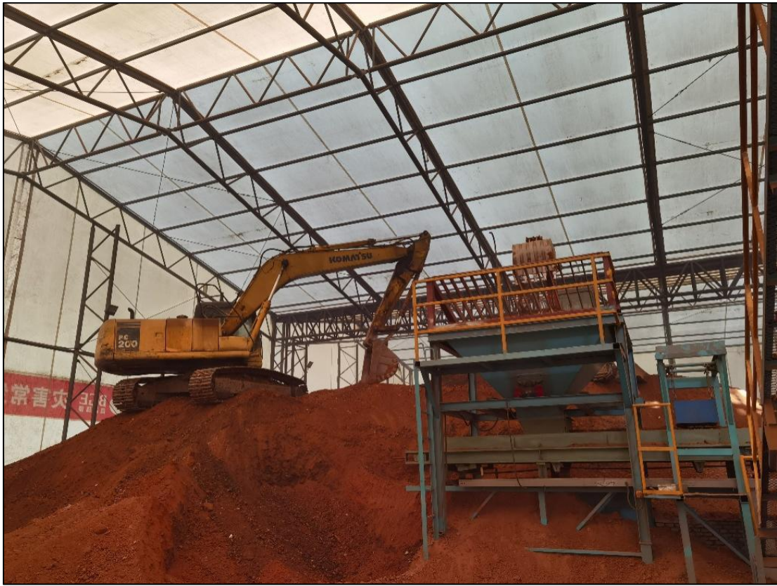
图 3.4-7 1#基坑污染土壤进料系统
