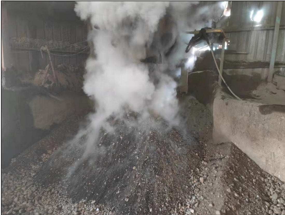
图 3.4-8 1#基坑污染土壤热脱附后出土
