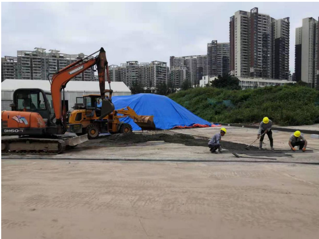
图 3.4-10 有机污染土待检区防渗结构建设
