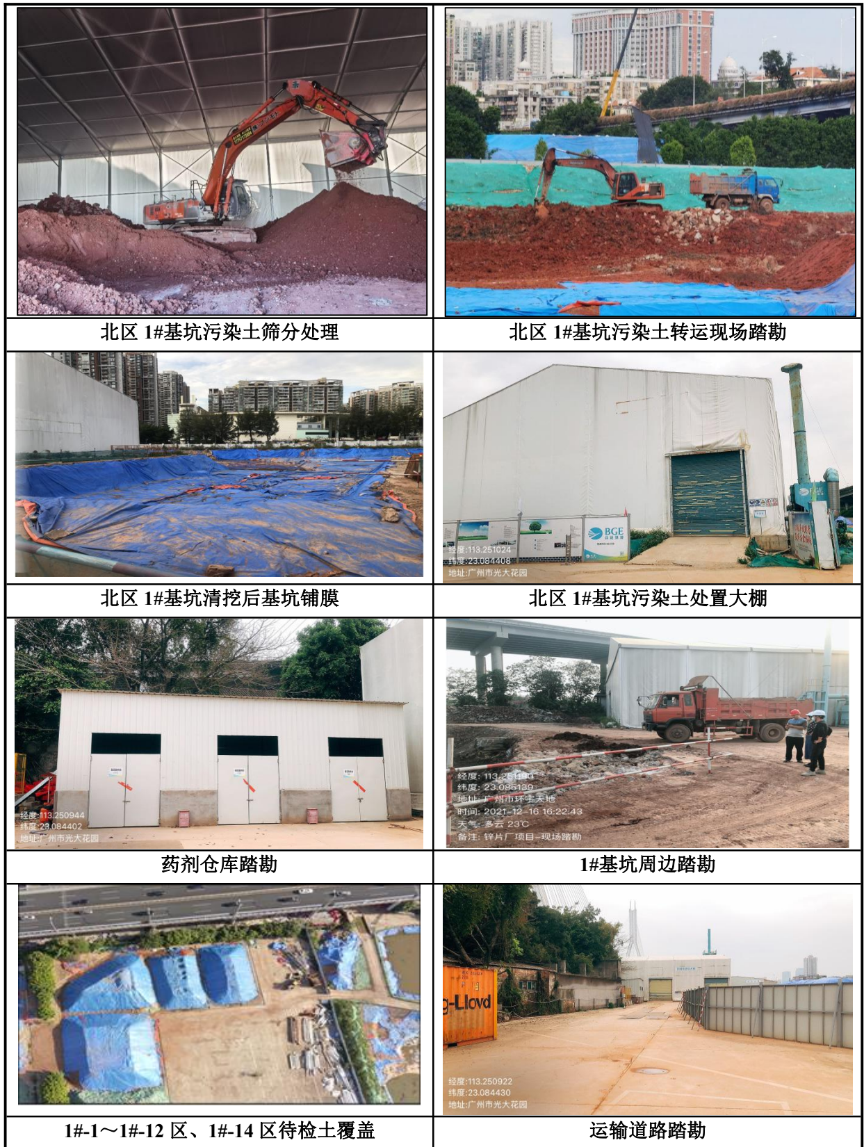
图 4.2-1 现场踏勘记录
