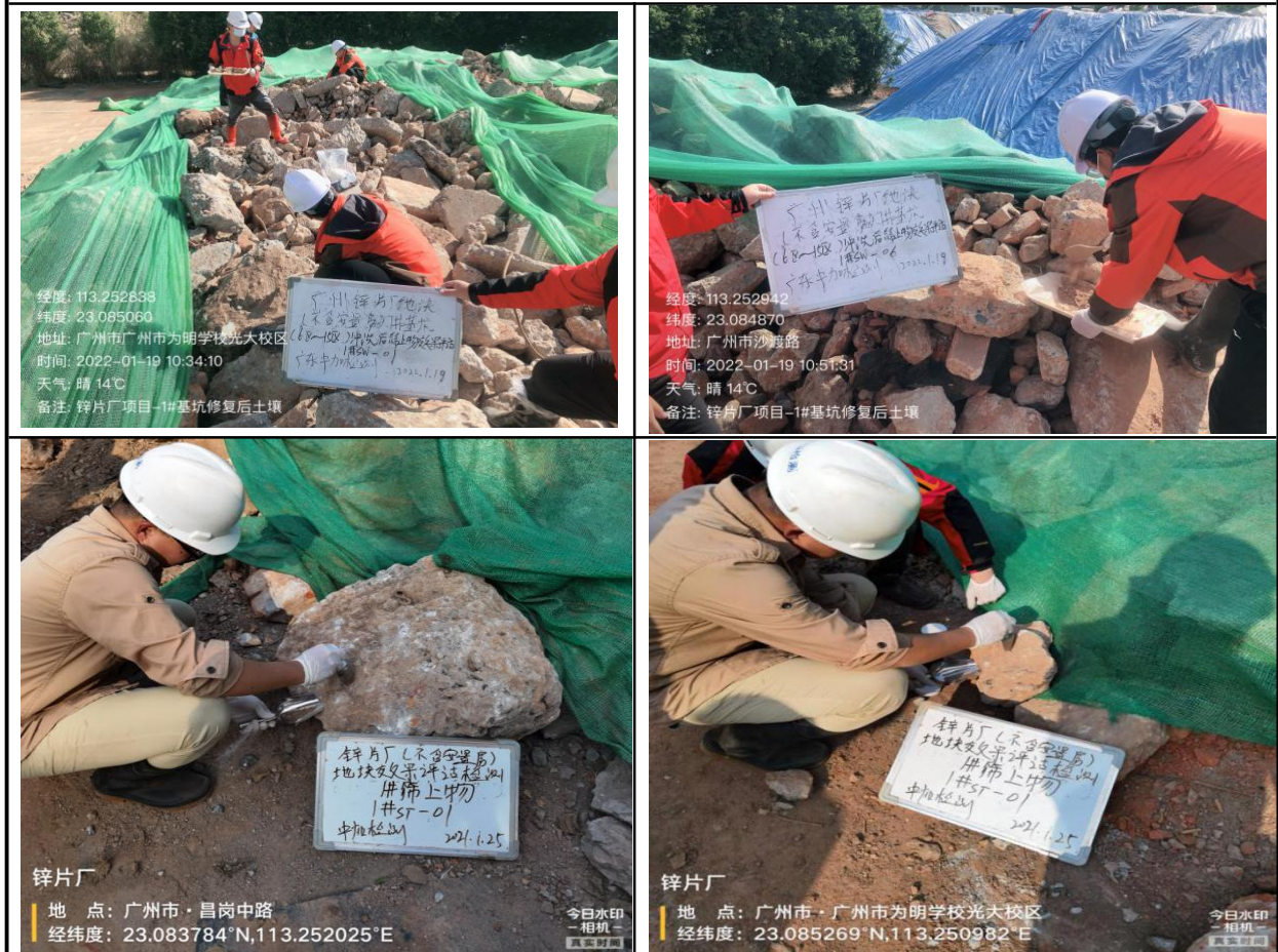
图 6.1-5 1#基坑（1#-1 区~1#-15 区）污染土筛上物采样图
