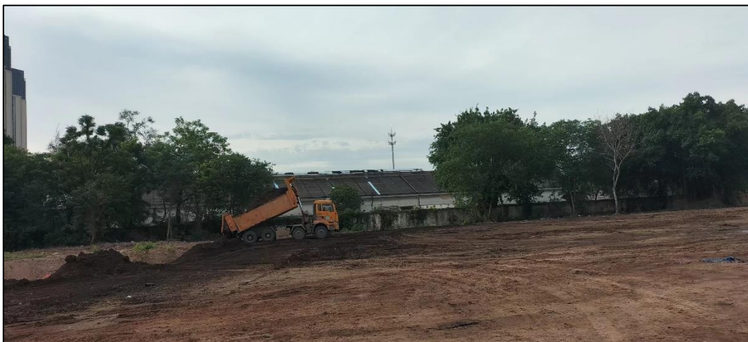
图 3.2-52 基坑回填
